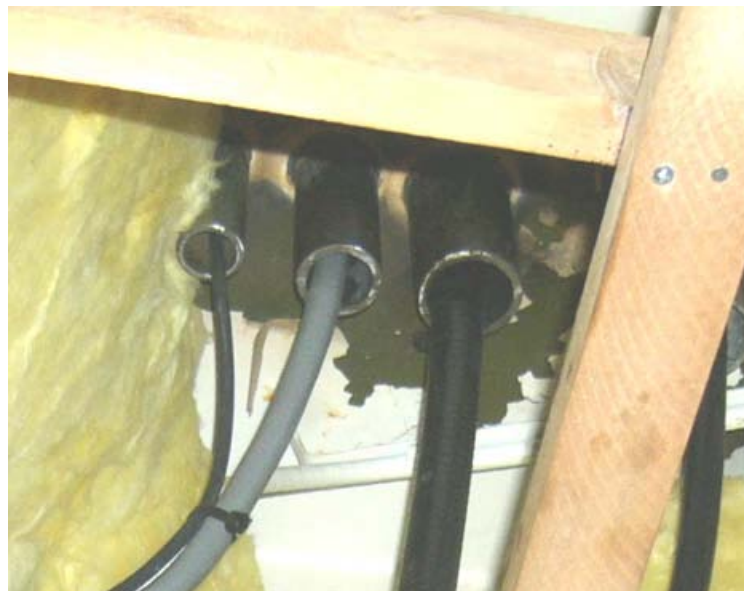
Fig. 1.3.11 Thru-deck cable gland
